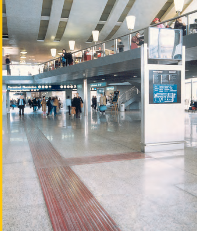
Percorso tattile nella stazione di Roma Termini, anch'esso in gomma. Nella zona commerciale (livello -1) sono state utilizzate le piastrelle in grès inserite nella nuova pavimentazione, con ottimi risultati di percepiibilità e di durata
