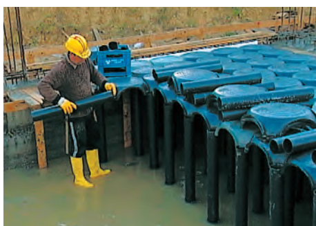
Un solaio con Iglù durante la fase del getto
