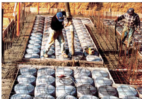
Un solaio con Iglù durante la fase del getto
