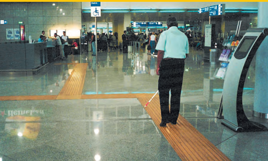
Percorso tattile nel nuovo aeroporto di Atene. Il linguaggio LOGES è stato utilizzato in tutti gli aeroporti italiani ristrutturati. Per gli interni, il materiale ideale con cui realizzare i percorsi è la gomma, che può anche essere incollata sul pavimento preesistente
