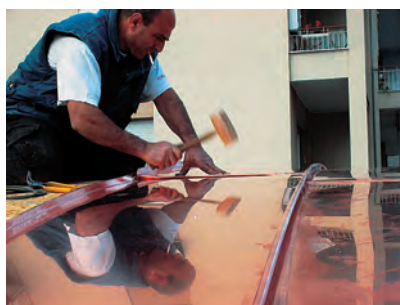
Una fase del montaggio delle scossaline
