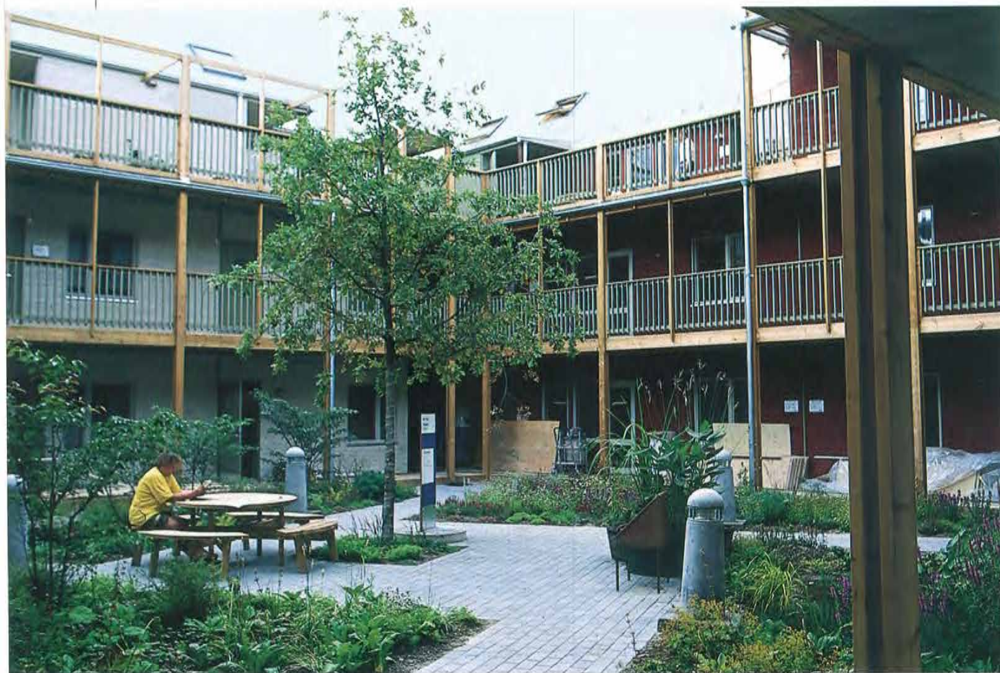
Interno di un isolato di case a ballatoio
