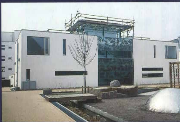
Pareti a pannelli solari per il riscaldamento dell'acqua ad uso sanitario nel giardino d'inverno dell'abitazione norvegese nel Villaggio europeo
