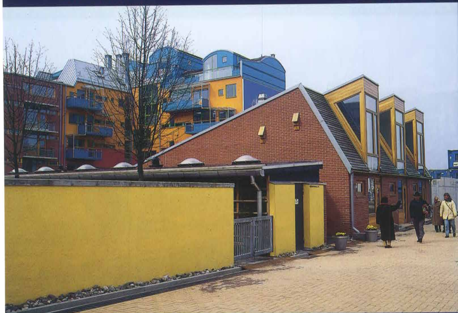
Strada di servizio alle pertinenze
