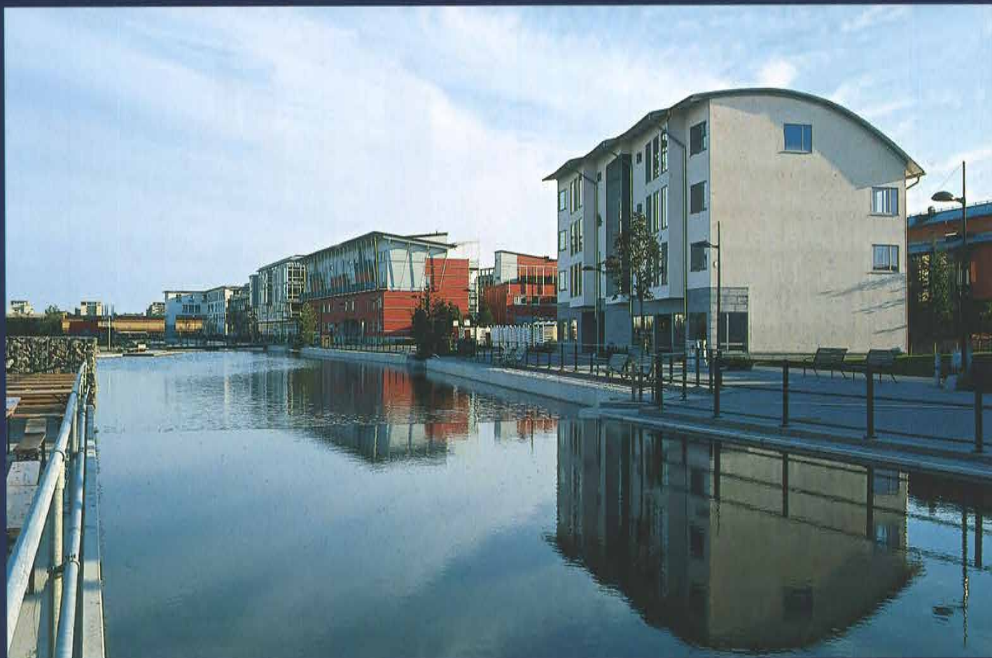
L'innesto del canale all'ingresso del quartiere residenziale
