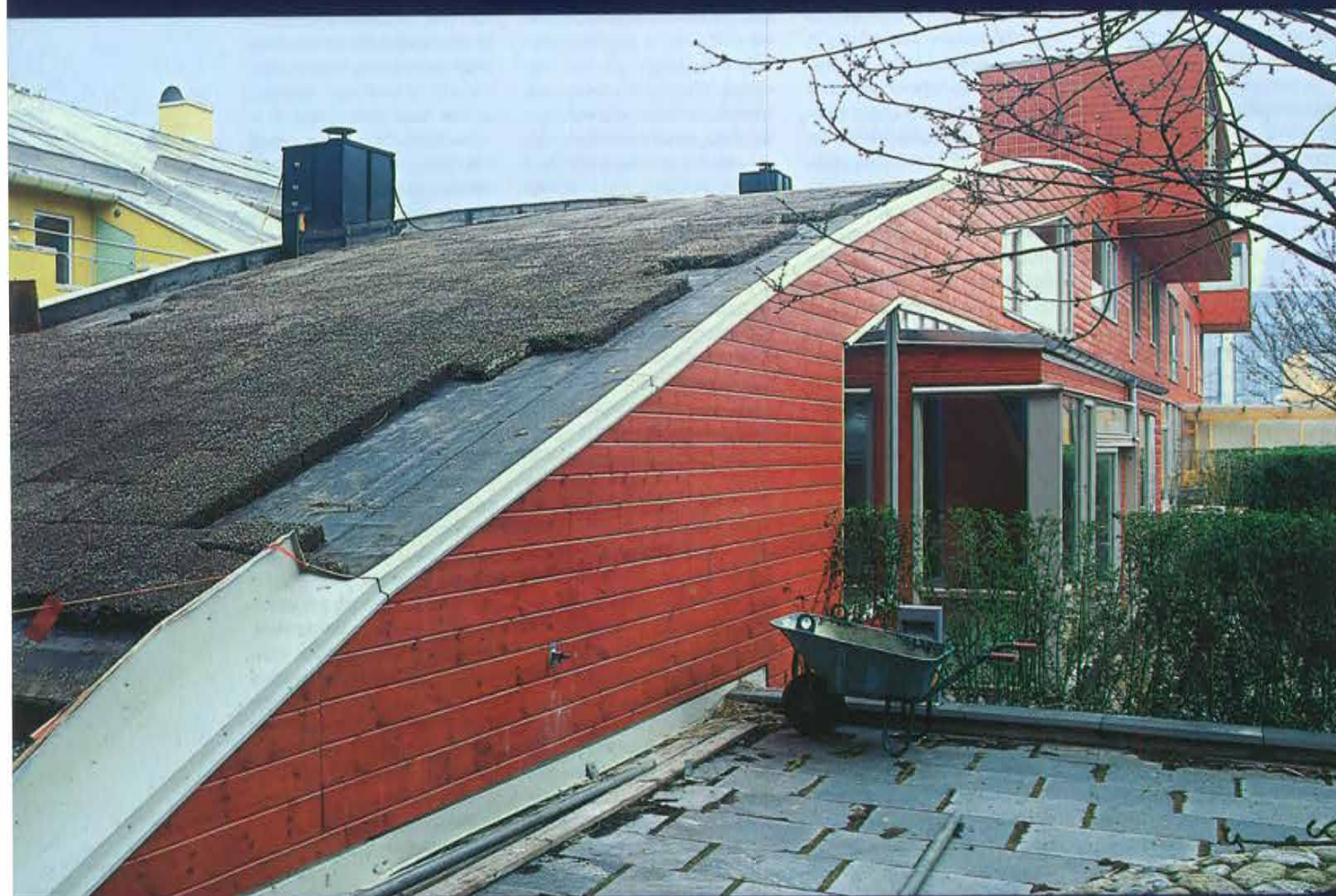
Preparazione dello strato di coibentazione del tetto a base di leca granulare. La copertura viene successivamente completata con impianto di essenze vegetali a forte capacità di assorbimento idrico
