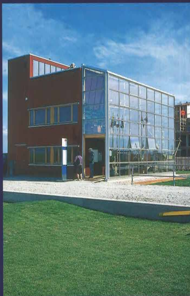
Pareti a pannelli solari per il riscaldamento dell'acqua ad uso sanitario nel giardino d'inverno dell'abitazione norvegese nel Villaggio europeo
