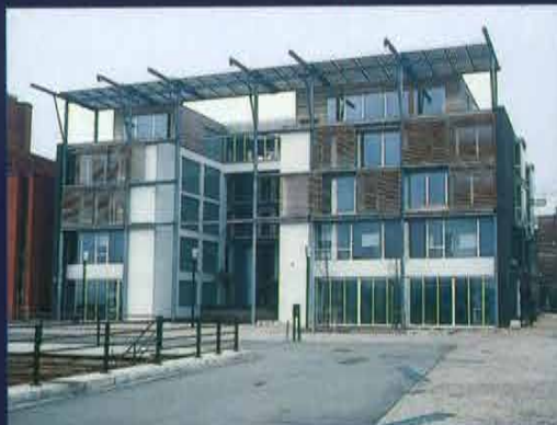
Brise-soleil ottenuti con pannelli a cellule fotovoltaiche per il riscaldamento dell'acqua ad usi sanitari
