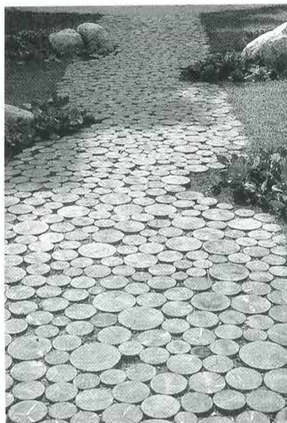
Pavimentazione ottenuta con l'accostamento di tronchi di alberi di sezioni diverse
