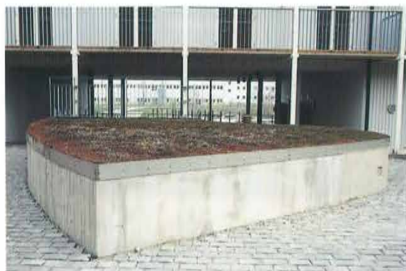
Rivestimento con sedum della presa d'aria dei garages
