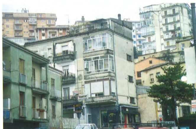
La veranda in alluminio anodizzato (al centro), fustosto epilogo di molti balconi concepiti in assenza di progetto
