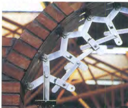
Sistema di centinatura ad assetto variabile. Esempi di applicazione
