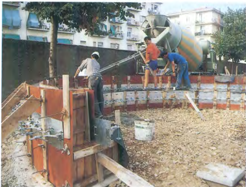
Sistema di centinatura ad assetto variabile. Esempi di applicazione
