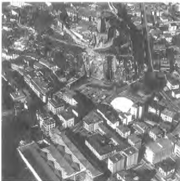
Veduta aerea della piazza. Da qui si scorge quale fosse la condizione del sito prima che venisse realizzato il progetto per la nuova sistemazione di Piazza del Sole. Come si può vedere, l'area era utilizzata a parcheggio di superficie, mentre il costolone roccioso era già stato messo a nudo con l'estirpazione di tutte le piante
