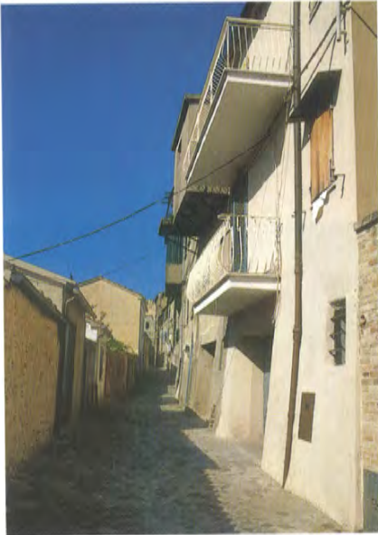
Sovrapposizione casuale di balconi all'interno del tessuto storico con ingerenza sullo spazio pubblico. Una condizione ricorrente che costituisce un elemento di forte degrado
