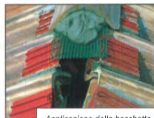
Applicazione delle bocchette di ventilazione sulla linea di colmo
