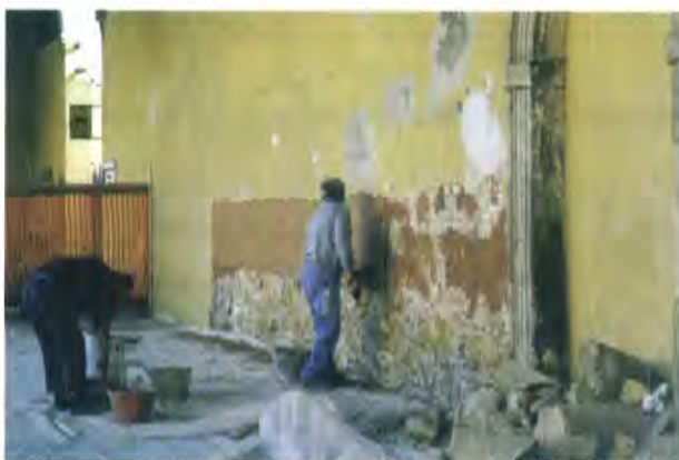
Applicazione sulla muratura del primo strato di intonaco deumidificante a base di cocciopesto
