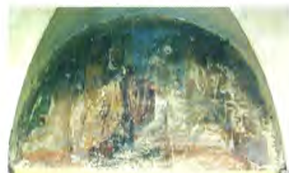
Prima del restauro
