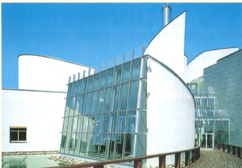
Sistemi in alluminio Schüco FW 50+S e S.1. La Schüco presenta la nuova serie FW 50+.
