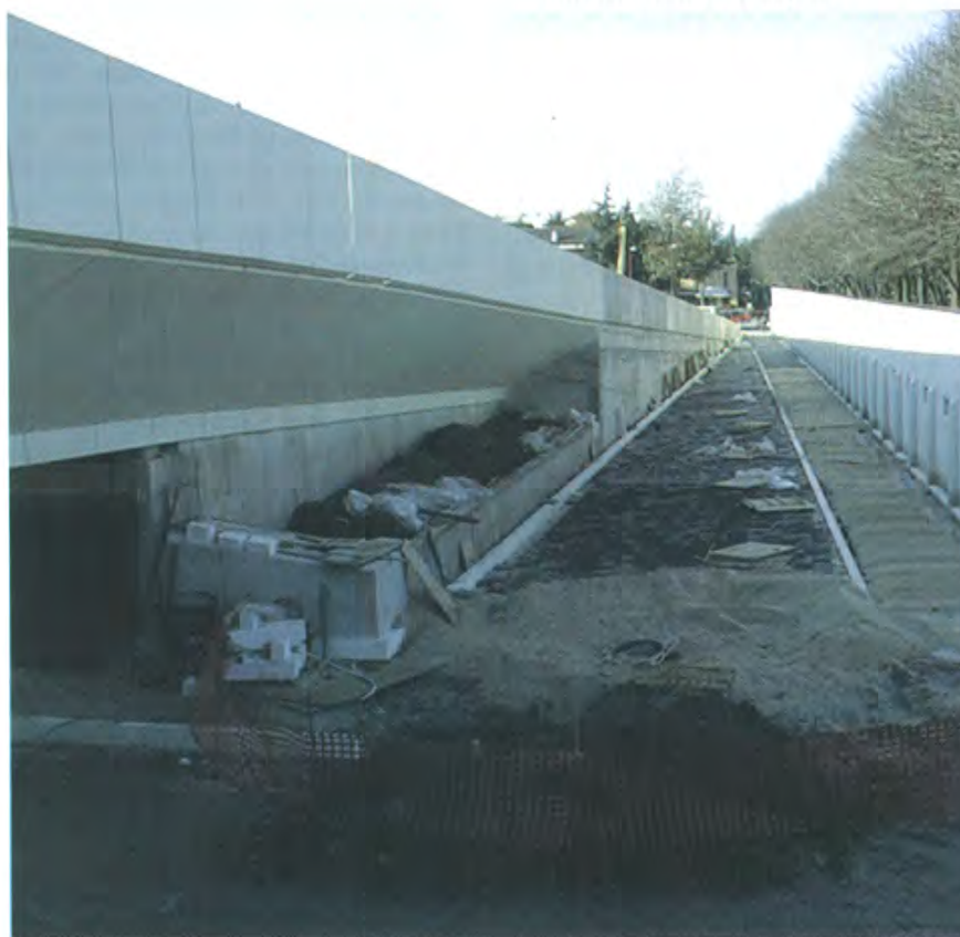
Vista ravvicinata del nuovo ponte
