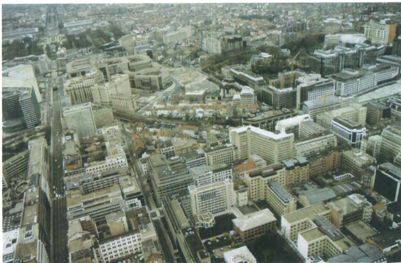
Gli isolati otto-novecenteschi e le grandi arterie del traffico urbano
