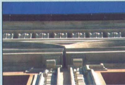
Particolare del fronte principale ripreso dopo gli interventi di restauro
