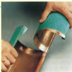
Connessione delle grondaie
