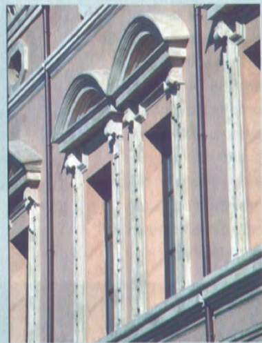
Particolare del fronte principale ripreso dopo gli interventi di restauro
