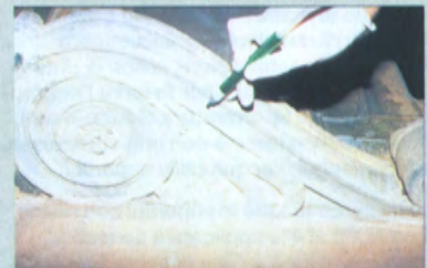
Pulitura delle mensole esterne con "airbrush" a pressione atmosferica controllata e bisturi
