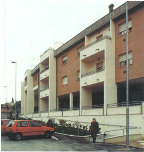
L'accesso da est con il portico e la rampa
