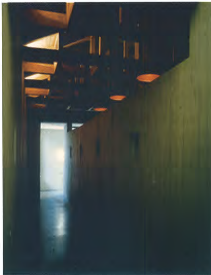
La copertura lignea vista dal "matroneo" che si affaccia sulla doppia altezza della sala (Foto di Mao Benedetti)
