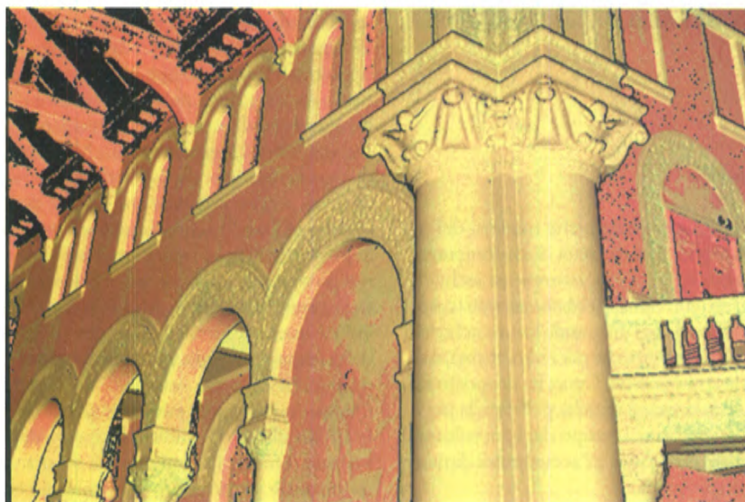
"Shinkwrap" di un particolare interno della navata della Cappella della Stanford University, California, USA; rilievo a 475.000 punti
