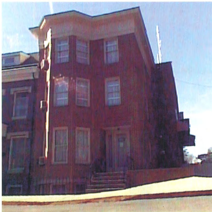
Immagine fotografica e "shrinkwrap" di Hogan's Alley, struttura d'allenamento dell'FBI, Virginia, USA; rilievo a 1.000.000 punti
