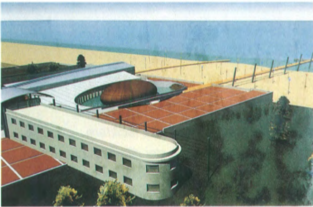
L'edificio della colonia marina, in primo piano, in grave stato di degrado, recuperato nella riprogettazione dell'area.
