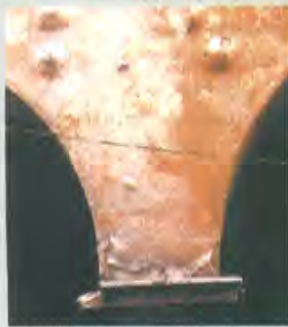
Rigonfiamento. Sollevamento superficiale e localizzato del materiale (intonaco e/o pellicola pittorica) che assume forma e consistenza variabili.
