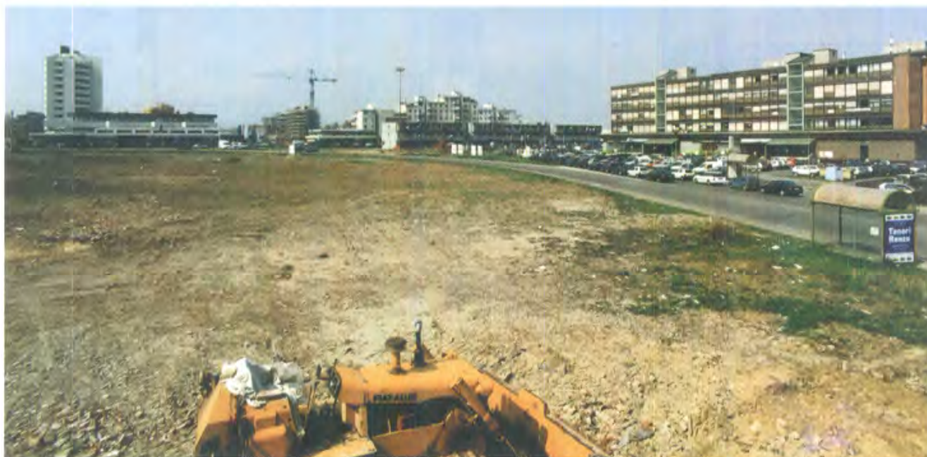
Vista dell'area dismessa contigua alla circonvallazione di Sassuolo.
