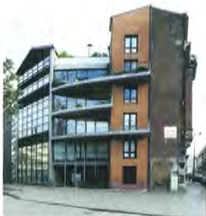
Impasse Charrière. Immobilie abitativo e commerciale per l'azienda immobiliare municipalizzata della Ville de Paris, architetto Massimiliano Fuksas. L'opera è addossata ad un immobile che dà su strada (a destra) di cui è visibile il pignone
