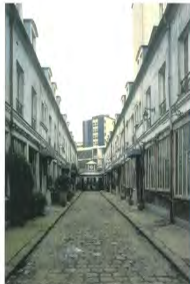
Il cortile al 18 rue de Reuilly. La commistione di destinazioni d'uso si traduce in sovrapposizioni: esercizi e laboratori al pianterreno, alloggi ai piani
