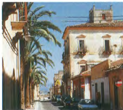
Palazzo nobile e chiesa di San Rocco su piazza Umberto
