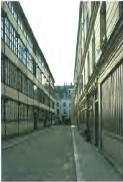
Il cortile al 41 rue de la Roquette-28 rue Sedaine. Gli immobili mono-orientati addossati ai muri di separazione sono spesso costruiti con le stesse modalità, sia nel caso di edifici commerciali con armatura in legno (a sinistra) o di immobili residenziali (a destra)
