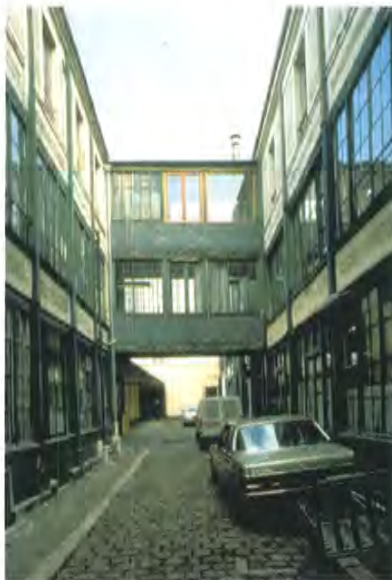
Il cortile al 77 rue de Charonne. L'edificio commerciale ad U, nel quale ogni piano è collegato per mezzo di una corsia in metallo, delimita lo spazio di un cortile di notevole ampiezza. L'edificio è sempre occupato da diversi esercizi
