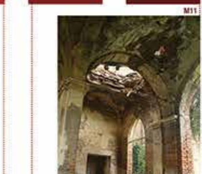
Crollo della volta con mattoni disposti in foglio.
