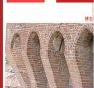
Foto dei danni ad elementi sporgenti, quali archetti e beccatelli del mastio.
