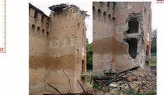
Lesione (20 maggio 2012) e successiva espulsione (29 maggio 2012) dell'angolo nella torre d'ingresso settentrionale, dovuta alla messa in opera di solai in cemento, durante un restauro precedente.
