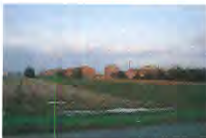
Gli anni '80 hanno confermato l'incapacità di qualificare chiaramente ambiti territoriali di margine, con una chiara connotazione rurale, ricorrendo contemporaneamente a diversi modelli residenziali, quali case a schiera, case a torre e blocchi in linea senza che ciò comportasse la volontà di ridisegnare dei limiti della città
