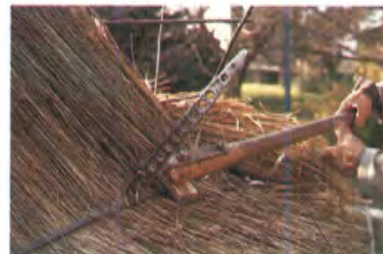
Fase di copertura: prima stretta della legatura
