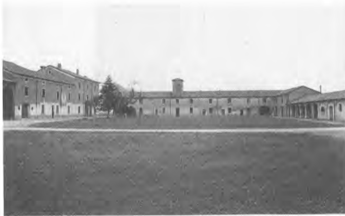
Cascina "La secca" nel territorio di Monticelli d'Ongina (Piacenza). Insediamento rurale ancora attivo di valore storico architettonico
