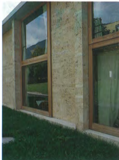
Particolare della muratura
