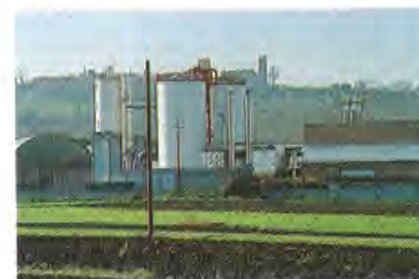
Assemblaggi di forme cilindriche, capannoni voltati, massicci parallelepipedi, utilizzati per impianti a servizio della zootecnia, scandiscono il paesaggio lungo la via Emilia tra Rimini e Cesena. La disposizione seriale sui margini della strada contribuisce a creare un'immagine di periferia industriale continua
