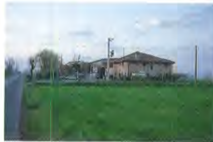
Un esempio di ricorrente contaminazione tra edilizia rurale e capannoni industriali, che modifica in maniera irreversibile il rapporto tra abitazione ed annessi di servizio
