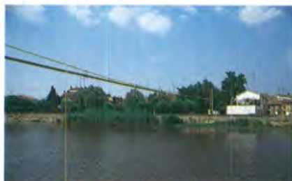
Immagine dell'area lungo il fiume (area progetto n. 5), vista dall'argine destro del Volano
