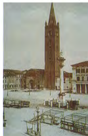
Un'immagine fotografica della piazza a cavallo del secolo. È visibile la facciata dell'abbazia di San Mercuriale (non ancora reinterpretata dai restauri del 1921) con il suo sagrato delimitato da fittoni in pietra d'Istria. Il chiostro del convento diverrà, con i lavori del 1939, un porticato passante su piazza XX settembre.
