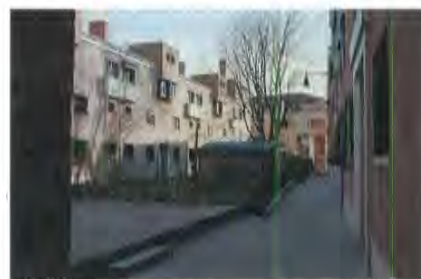
Fig. 16 Il Campo del Camin risulta essere uno spazio concluso che media il passaggio dagli impianti attestati sulla Fondamenta Savorgnan e quelli convergenti sul loggiato a doppia altezza
