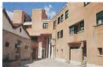
Fig. 15 Il raccordo tra Calle Priuli Dei Cavaletti e Calle della Misericordia visto da quest'ultima
