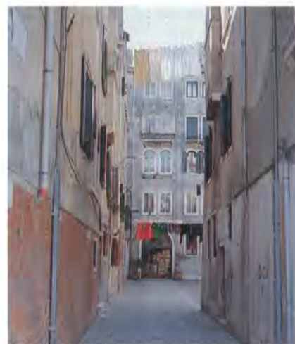
Fig. 3 L'ingresso all'isola dalla calle della Colombina, perpendicolare alla Fondamenta Savorignan
