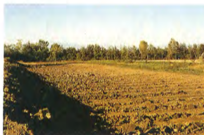
Mandiferro (San Vito al Tagliamento). L'area di intervento all'inizio dei lavori
