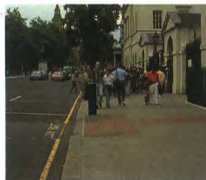
Whitehall, Londra. Pavimentazione a "bolle" di colore rosso per segnalare un attraversamento pedonale controllato
