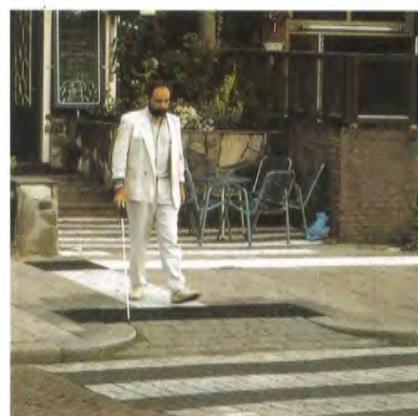
Apeldoorn. Percorso guida, differenziato per texture, rugosità superficiale e contrasto cromatico dal resto della pavimentazione, che conduce ad un attraversamento pedonale
