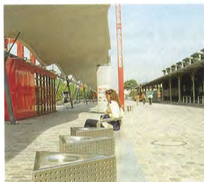
Parco della Villette, Parigi. Portico con una larghezza sufficiente a generare una zona d'ombra "utile" ad un ipovedente
