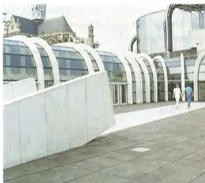
Forum des Halles, Parigi. Percorso pedonale con una informazione visiva rinforzata contrastante con l'intorno
