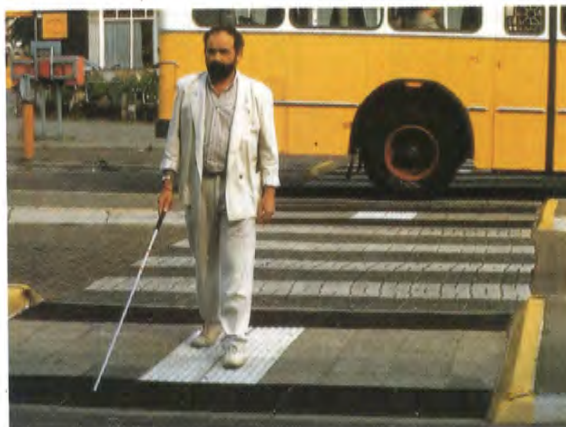
Apeldoorn. Utilizzo delle superfici tattili guida negli attraversamenti delle isole spartitraffico.
