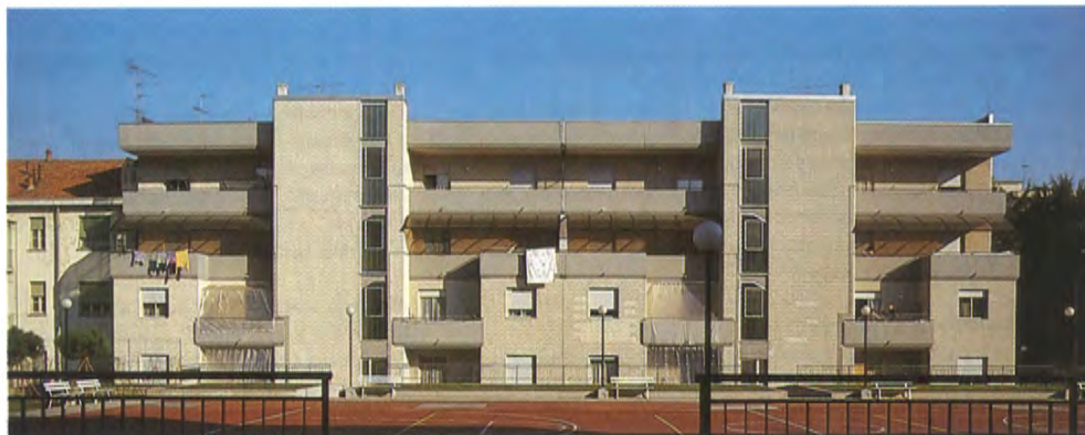
Veduta del retro dell'edificio
