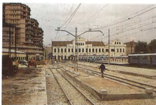
Lo stato precedente i lavori sulla linea 4
