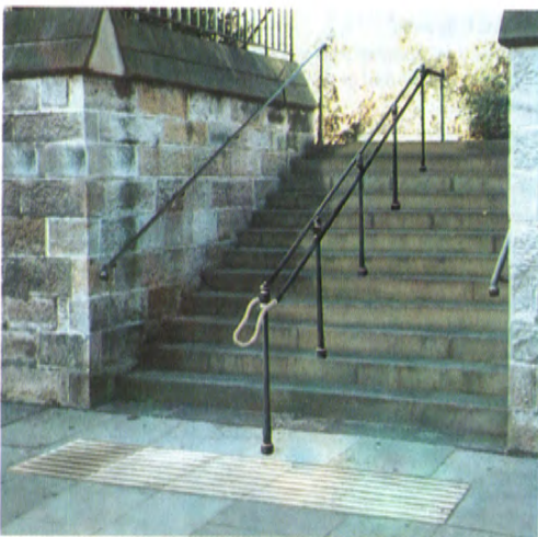
Particolare della scalinata e della rampa tra i passaggi pedonali
