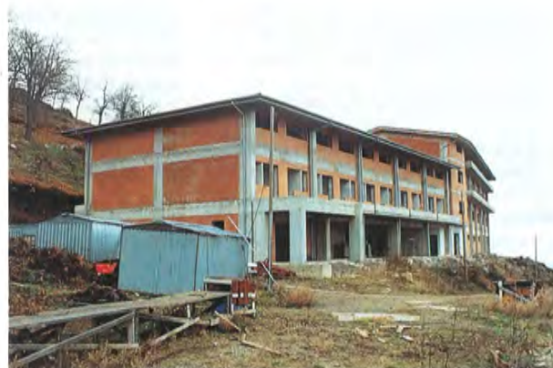
Ripresa dell'edificio in fase di costruzione
