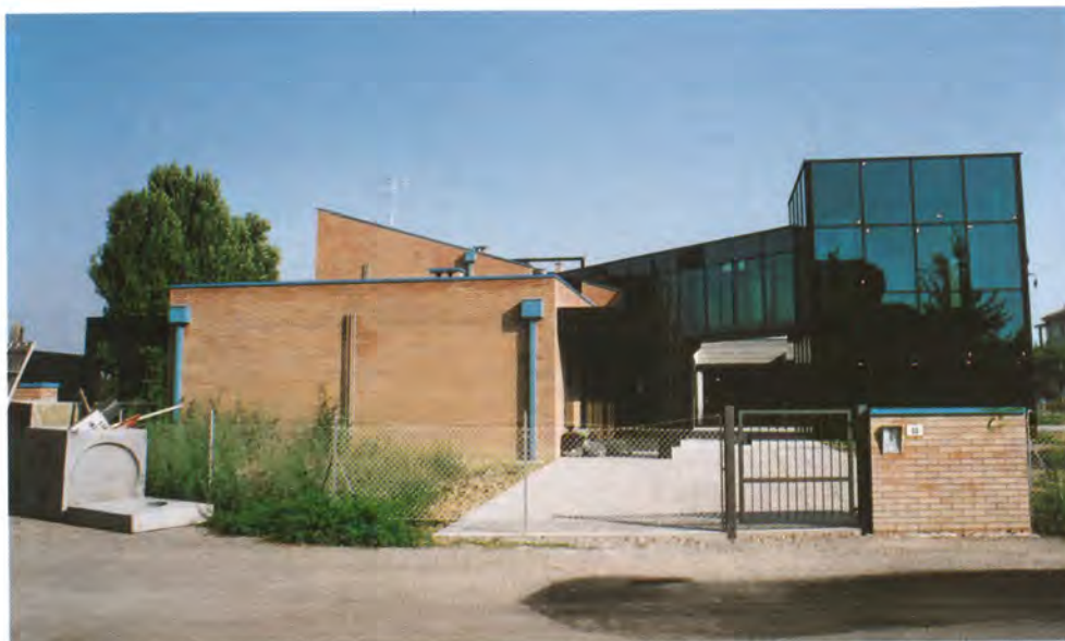
Veduta del fronte principale
