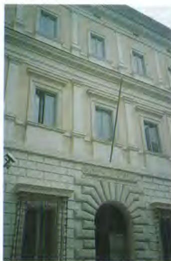
Facciata del palazzo Ossoli a Roma a seguito dell'intervento, 1993
