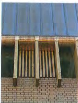
Schermatura di alcune canalizzazioni che attraversano il piano del ballatoio fra i brise-soleil in legno lamellare.
