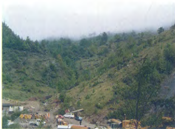
Vista n. 1 - Stato di fatto
