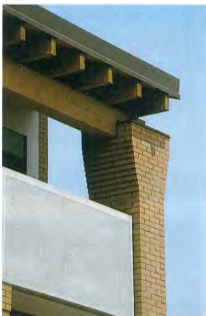
La trave di bordo avvolta dal capitello dei pilastri.
