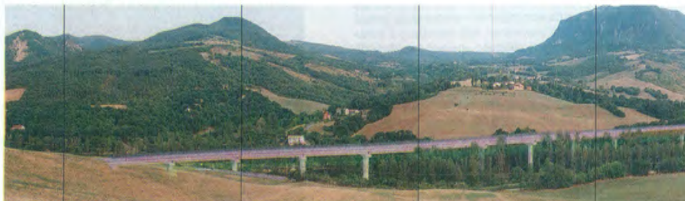
Vista n. 3 - Perizia di variante (viadotto "Reno II")
