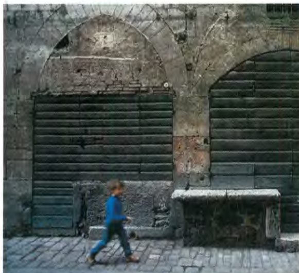
Il carattere dei luoghi dipende dalle "cose minori" (portoni tradizionali a Spoleto e uno nuovo nel centro storico di Perugia).
