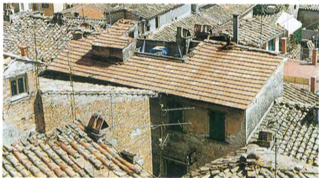
Perugia, tetti nella zona di Via Alessi
