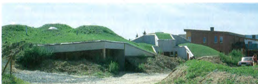
Insedimento realizzato dall'Arch. G. Minke a Kassell con adobe e coperture in terra (questa parte di intervento è stato realizzato tra il '90 e '93)
