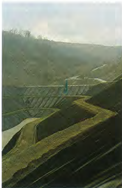
Il primo lotto di intervento a lavori ultimati
