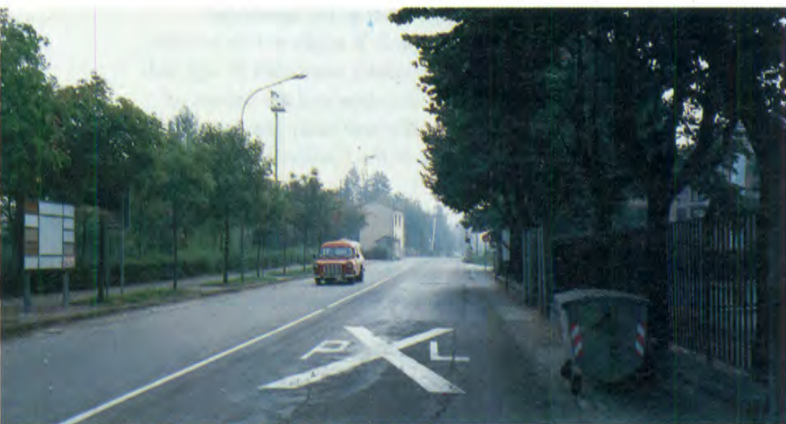
Il passaggio a livello all'interno del paese che sarà sostituito da un sottopassaggio automobilistico
