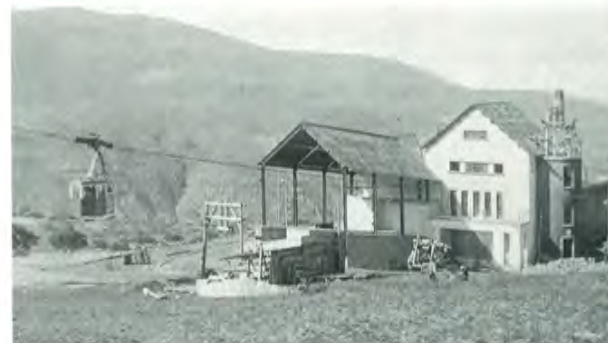
Immagini d'epoca. Stazione di Fonte Cerreto, lavori in fase di completamento, visibile la linea funiviaria
