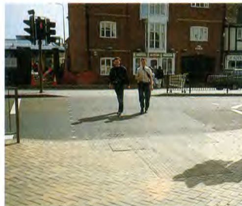
Esempi di pedana di raccordo e di attraversamento con valorizzazione dei componenti del piano di calpestio validi per persone con problemi di vista
