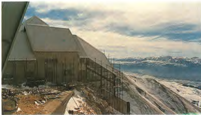
Stazione di monte anteriamente agli interventi di ristrutturazione.
