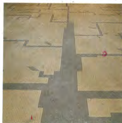
Pavimentazione di ingresso.
