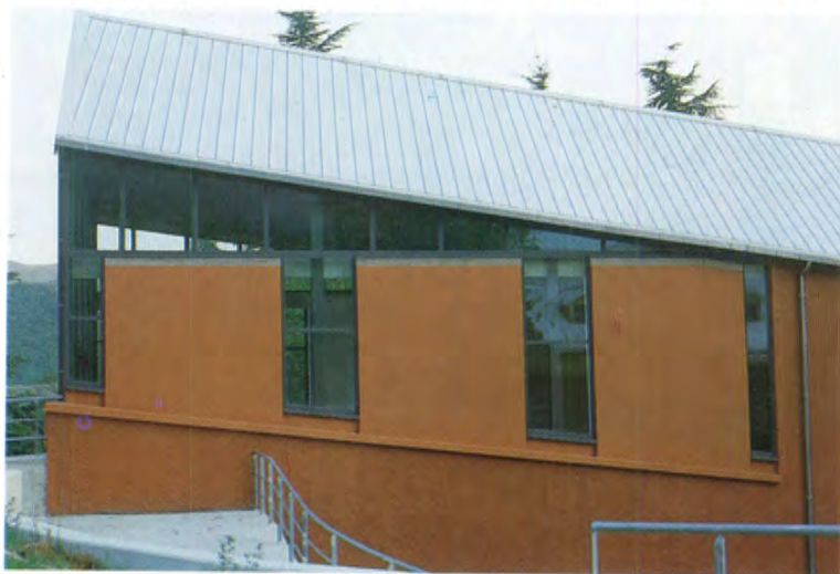
Particolare dell'innesco tra tamponamento e copertura, dopo l'intervento di recupero
