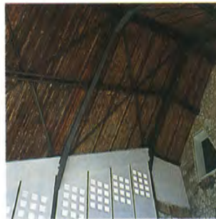
Stazione di monte. Vano di imbarco, recupero delle geometrie originarie
