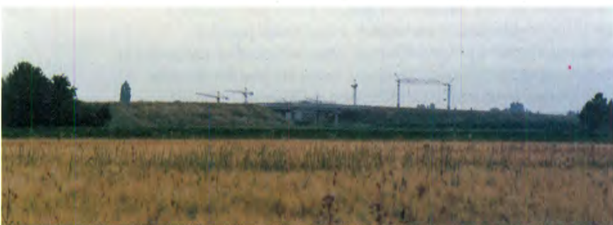
Il nuovo cavalcavia a nord già costruito
