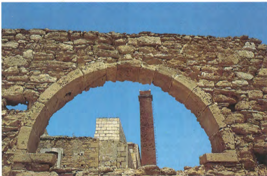
Avola, particolare, ampia luce arcata che caratterizza "la balata".
