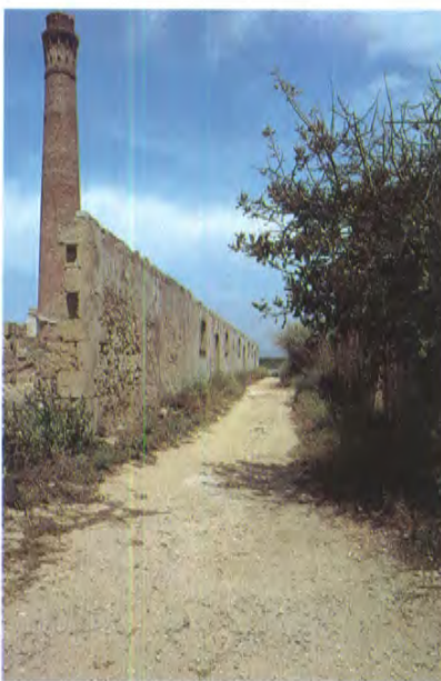
Vendicari, particolare del fronte Nord dello stabilimento, costruito ai primi del '900, per l'inscatolamento sott'olio del tonno; la ciminiera diviene un elemento caratterizzante il panorama della tonnara; solitamente di sezione quadrata, a Vendicari è circolare.
