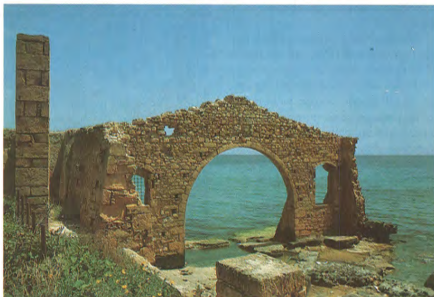
Avola, loggia della tonnara, detta anche balata; volumetricamente definita da pochi brani di muro; il fondo degrada verso il mare e consentiva un tempo un facile approdo per le muciare (barche relativamente piatte lunghe nove metri), che scaricavano i tonni per la pesatura.
