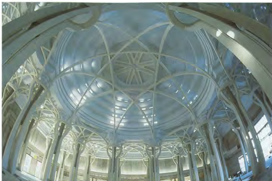
Moschea e Centro culturale islamico di Roma, particolare delle nervature e delle strutture in elevazione interne della moschea.
