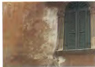
*Intonaco a base di cemento con numerose chiazze biancastre, dovute a sostanze caustiche presenti nella vecchia muratura e non eliminate preventivamente.*
