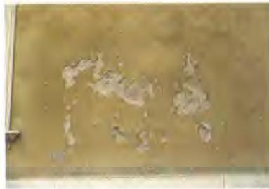
*Intonaco a base di cemento staccatosi dalla muratura per presenza di umidità di risalita.*
