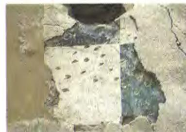
*Intonaco medioevale che presenta numerose picchiettature realizzate per ottenere una migliore adesione dell'intonaco sovrapposto posteriormente.*
