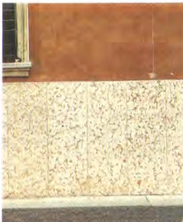
*Zoccolatura di un edificio composta da lastre di pietra, con superficie grossolanamente sbazzata. Tale esercizio, da impiegarsi con pietra locale, permette una buona traspirabilità del muro se la posa in opera delle lastre prevede una opportuna camera d'aria.*
