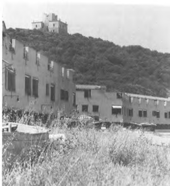
Il disegno delle logge caratterizza il fronte degli edifici
