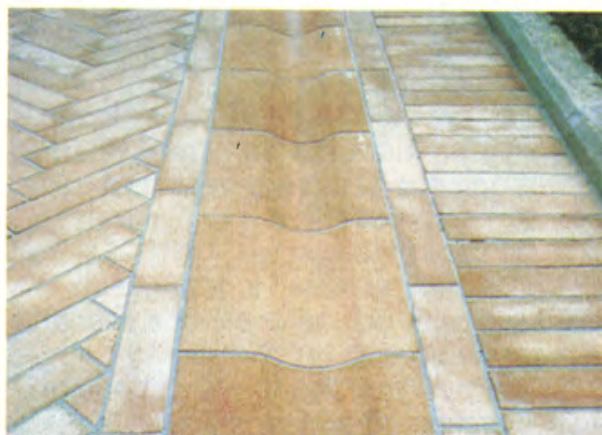
Pezzi speciali in cotto per l'arredo urbano e risoluzione di dettaglio per lo scolo delle acque
