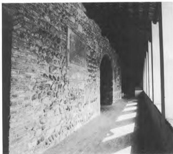
Elementi di pregio scoperti durante i lavori
