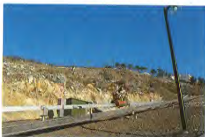
In alto il tratto più ripido del tronco Trans-Mobil® realizzato al "Pianeta Maratea" in salita verso il Grand-Hotel.
