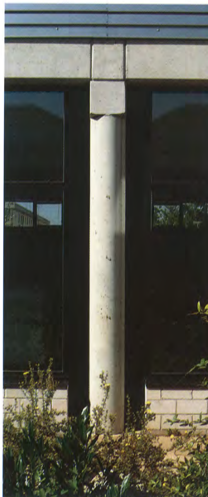
Particolare. Pilastro, infissi e tamponamento
