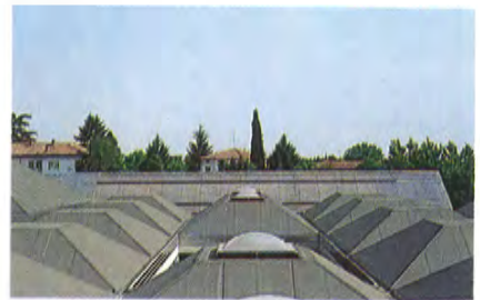
Veduta sulla copertura
