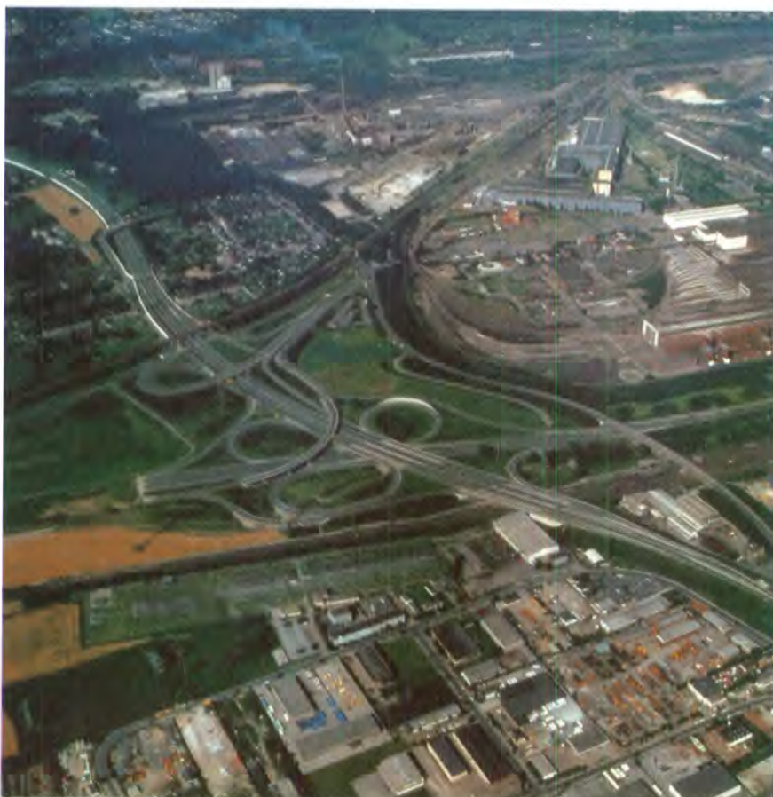
Esempio di rete stradale e ferroviaria nella Ruhrgebiet
